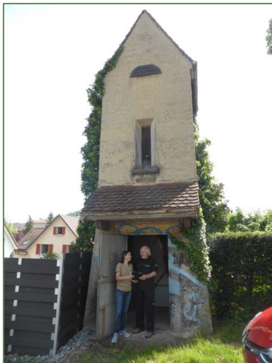
Unsere Artenschutz-Projektmanagerin mit dem Präsidenten des Stiftungsrates vor der stillgelegten Trafostation Frenkendorf, BL
