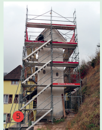
Ancienne tour de transformateur en cours de transformation à Dittingen © SPA_CH
