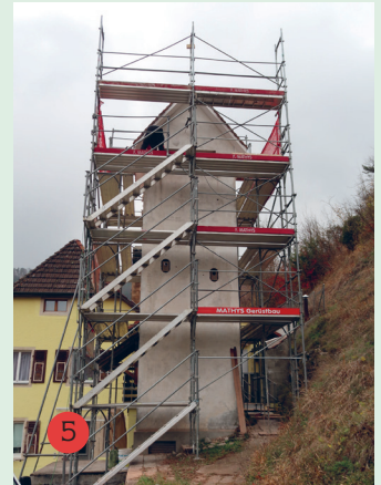
Ehemaliger Trafoturm im Umbau in Dittingen © SPA_CH
