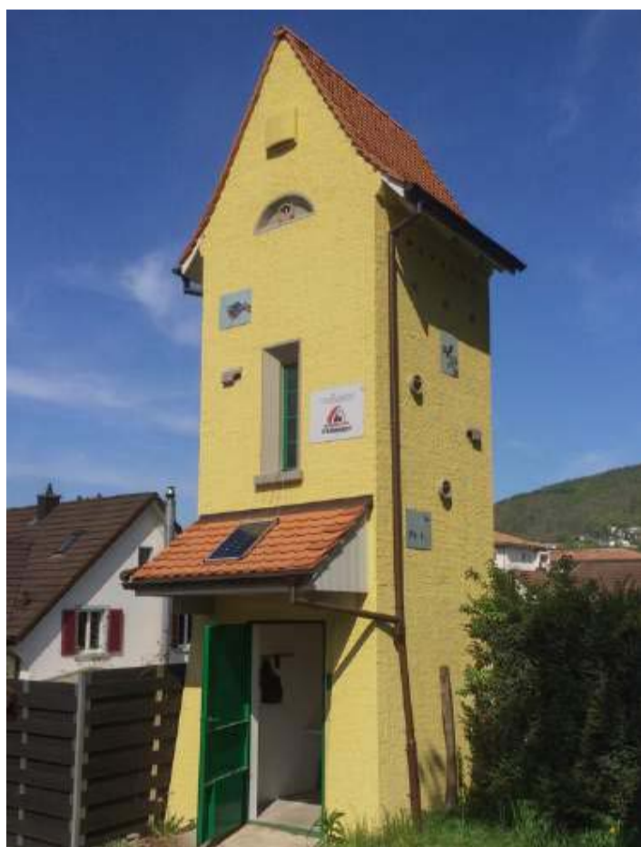
Im Artenschutzturm Frenkendorf/BL brüten die Mauersegler seit 2018 erfolgreich
