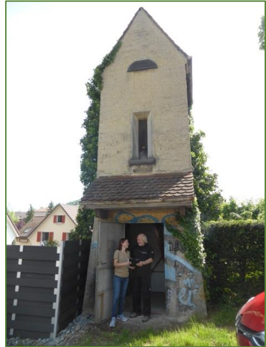
Unsere Projekt-Managerin mit dem Präsidenten des Stiftungsrates vor der stillgelegten Trafostation Frenkendorf, BL
