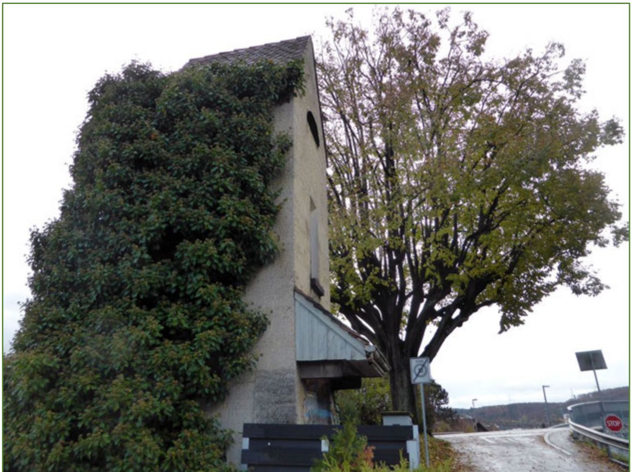
An der Nord- und Ostseite von Efeu überwuchertes Trafoturm in Frenkendorf, BL
