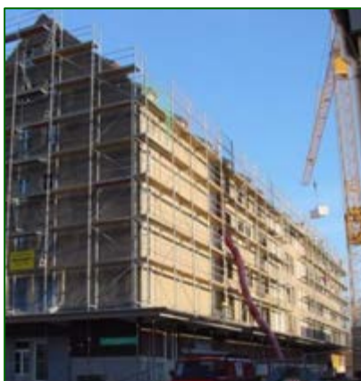
Sanierung eines alten Speichers
