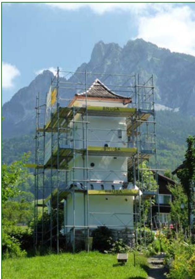
Artenschutzturm Maihof im Umbau
